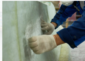
ซ่อมแซมพื้นผิวที่เสียหาย Surface preparation
